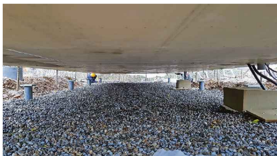
Das Aufsetzen des Moduls auf das Fundament erfordert Fingerspitzengefühl.
