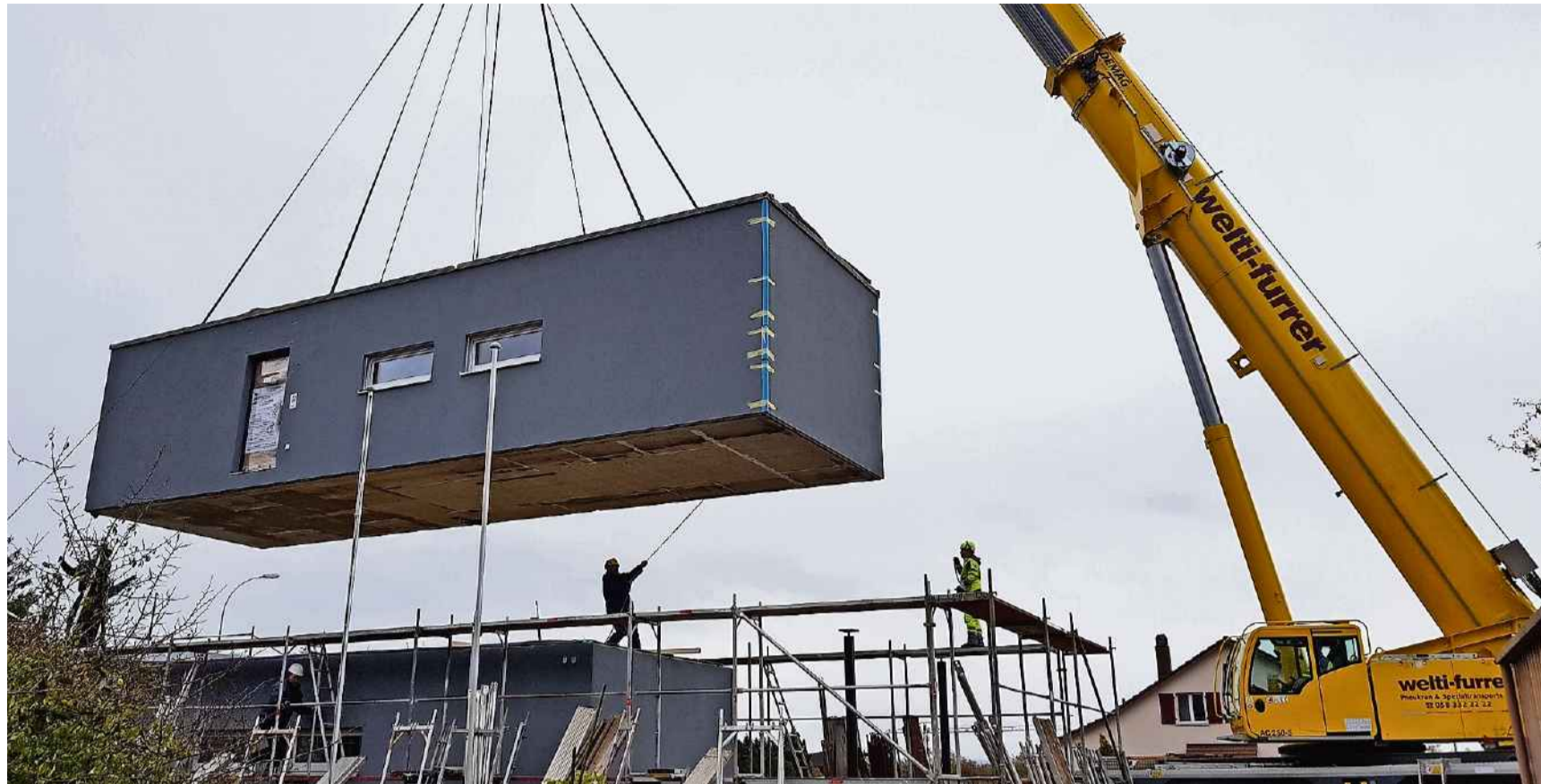
Die Wetterbedingungen für die Montage des doppelstöckigen Kleinhauses in Egerkingen waren nicht optimal. Trotzdem gelang die Installation.
