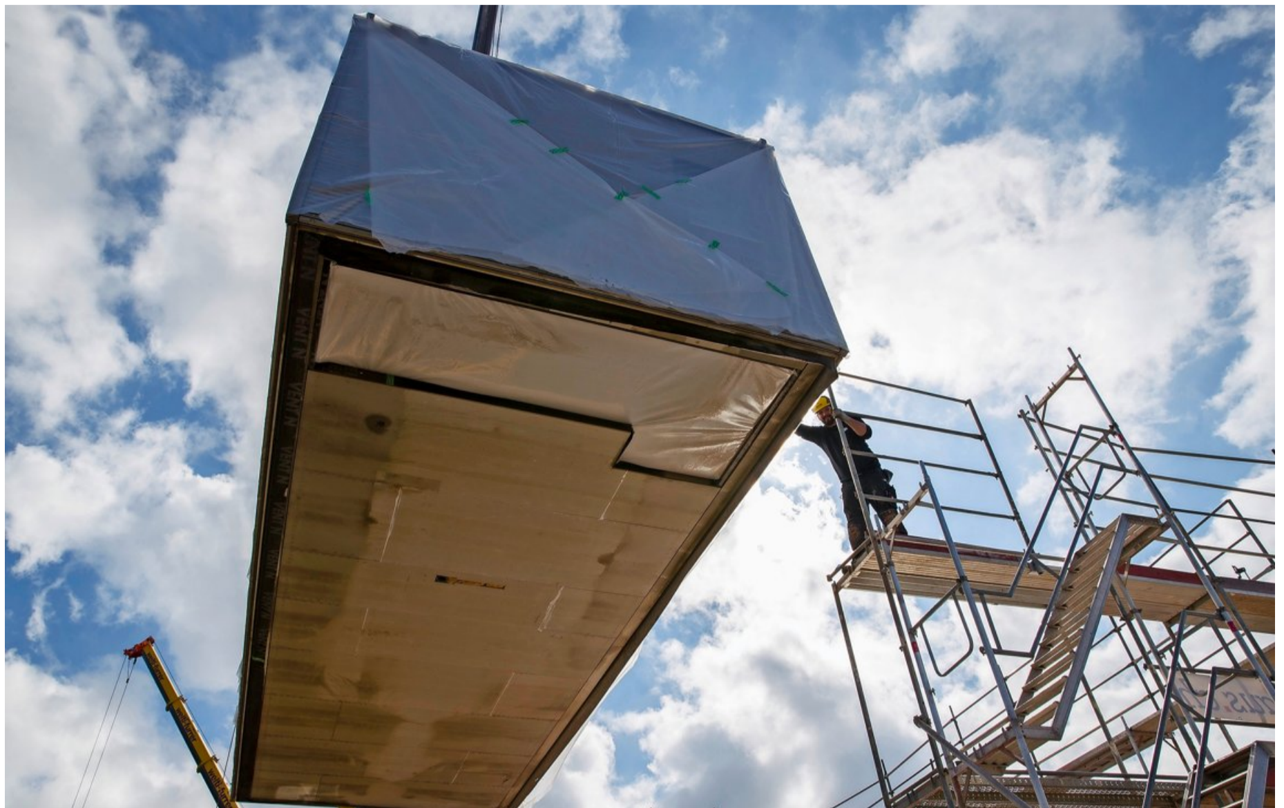
Ein Haus wird eingeflogen: Mit einem Spezialkran wurden die fixfertigen Module millimetergenau auf das vorbereitete Fundament gezirkelt.
