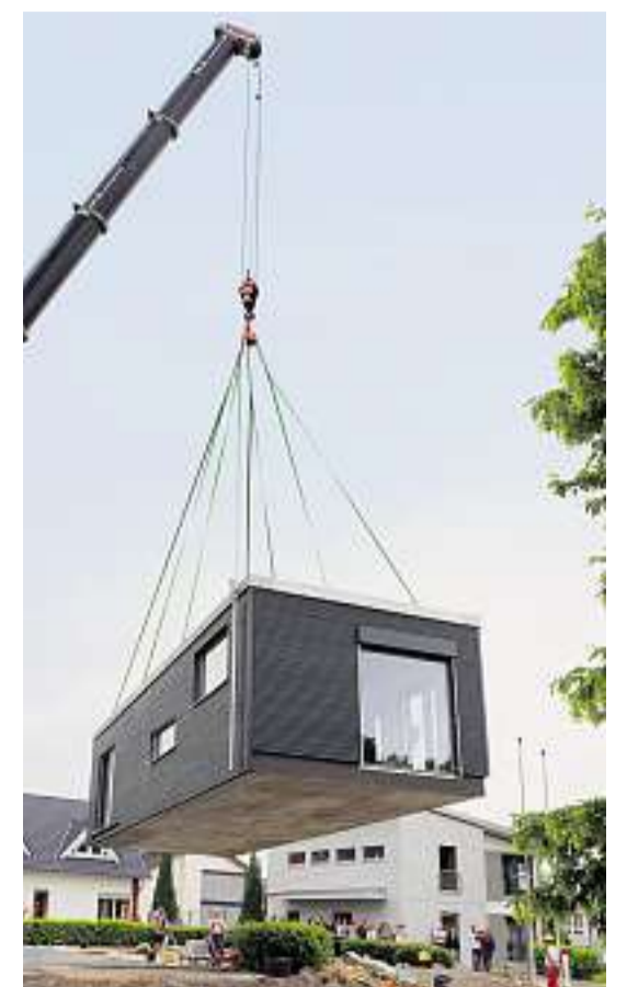
Ein FlyingSpace-Wohnmodul wird fix und fertig angeliefert, auf Wunsch sogar mit Einbaumöbeln. Beim Umzug nimmt man es einfach mit. Wohnmodule eignen sich auch sehr gut, um bestehende Gebäude aufzustocken. Ohne grosse und langwierige Eingriffe und ohne Behinderungen der Umgebung entsteht in kurzer Zeit attraktiver Wohnraum.
