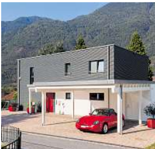
Haus Familie Allegri: Die Bauherrschaft hat sich vom zweigeschossigen Schöner-Wohnen-Haus inspirieren lassen, das im Schwörer-Musterhauszentrum am Firmensitz entstanden ist.
