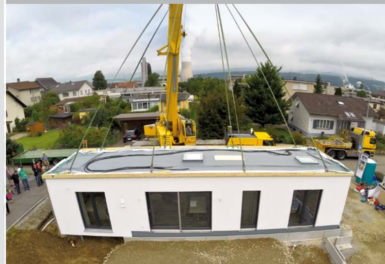
Mit einem Kran wird das Musterhaus angehoben und auf die vorbereiteten Punktfundamente gesetzt.
