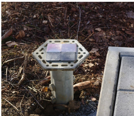
Schraubfundament 3,5 m im Boden verschraubt
