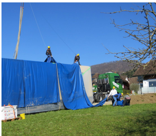
Spannung beim Entfernen der Blachen
