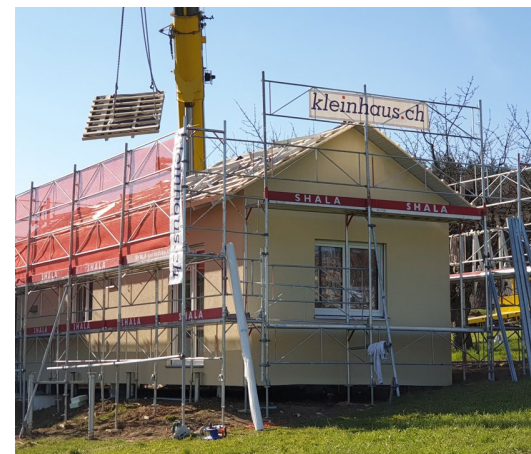
Die letzten Arbeiten am Satteldach
